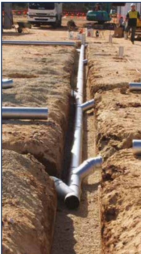
INSTALLATION EN ENTERRÉ
