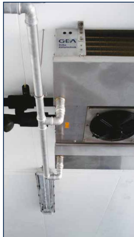
INSTALLATION EN SORTIE ÉVAPORATEUR
